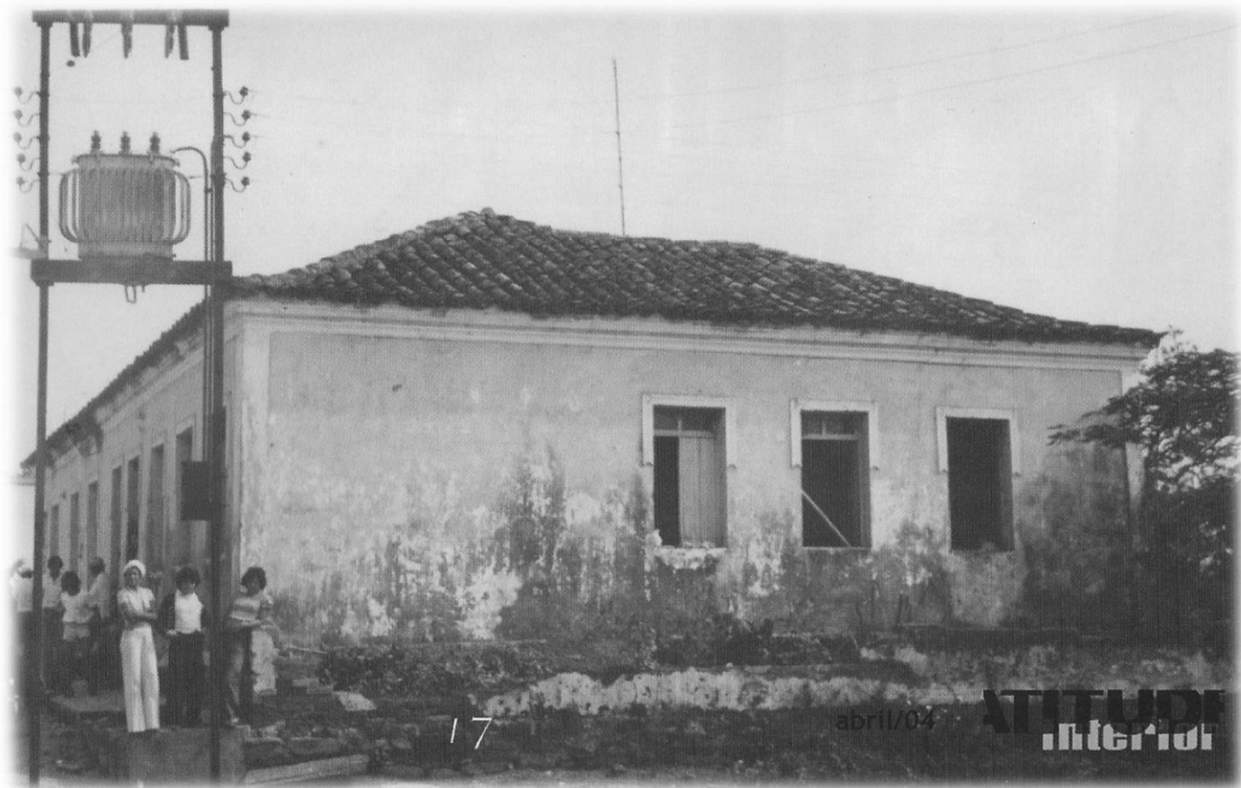
Casa onde funcionou uma antiga ferraria, sendo um dos seus proprietários o baiano Algemiro Rodrigues da Silva (Lico). Na esquina o único transformador do distrito, ponto de encontro nos finais de tarde. Fonte: Revista Atitude Interior, número 11, abril de 2004.
